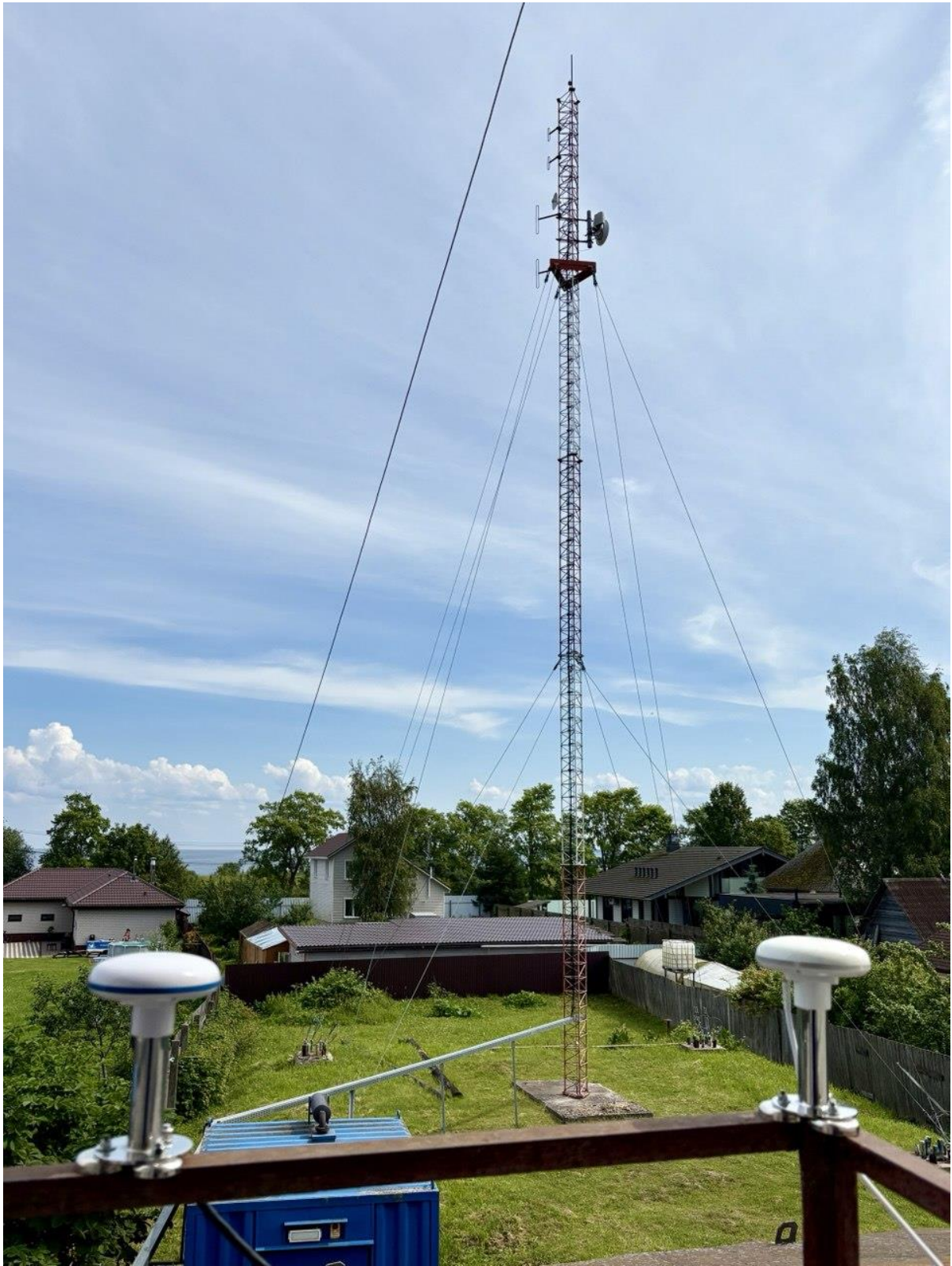
Фото 10 – Коллинеарная дипольная антенна УКВ диапазона RADIAL D2 высотой подвеса 25 метров (координаты установки мачты 59^{\circ}56.27094' С.Ш и 031^{\circ}3.20809' В.Д)
